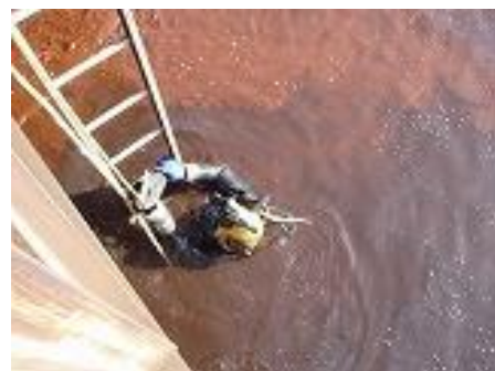
【汚水域での潜水作業状況】
