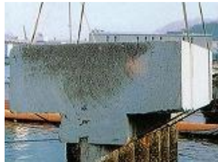
【ワイヤーソー切断断面】
